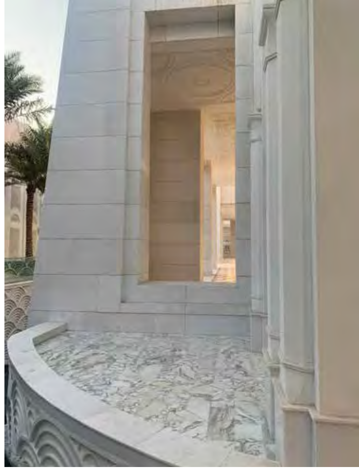
*Dış cephe Vietnam beyazı uygulaması. (Özel villa projesi, Katar)
